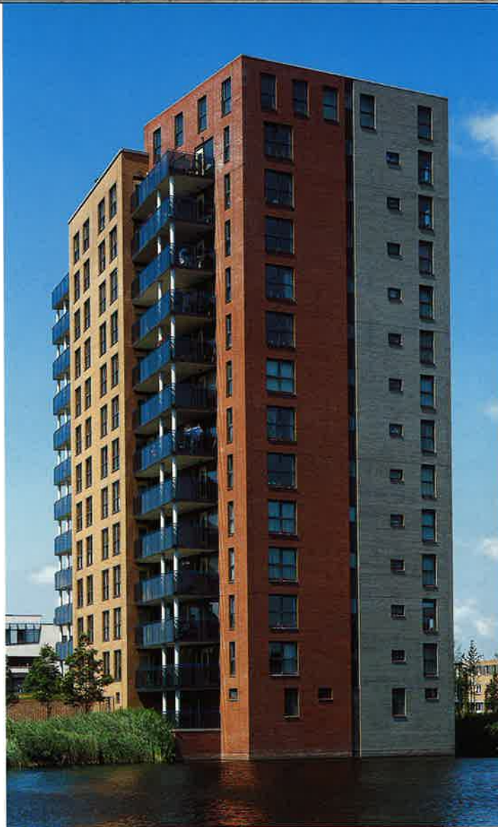
Woontoren Sloten, Amsterdam (KuiperCompagnons)
