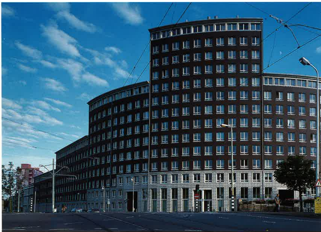
Woongebouw Huygenspark, Den Haag (Charles Vandenhove)
